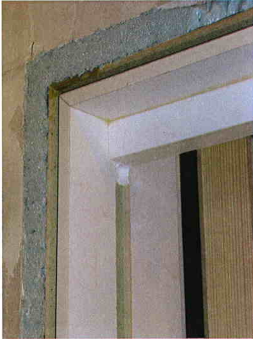
Le jeu entre l'hubriserie de la porte 1 et la cloison est comblé de mousse bicomposants 'HILTI CF 162' [1].
