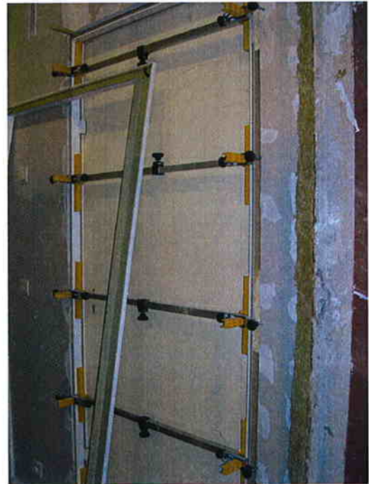
De omlijsting van deur 2 is aan zijn beide verticale stijlen ter hoogte van elke scharnier aan de wand over de volledige breedte van de omlijsting en over een afstand van 300 mm gelijmd met 'HILTI CF 101' 2 componentenschuim [2].
