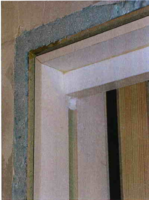
De speling tussen de omlijsting en de wand van deur 1 is opgevuld met 'HILTI CF 162' 2 componenten-schuim [1].
